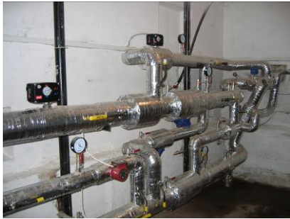
Тепловые пункты после реализации проекта / Контроллеры, установленные для каждого теплопункта
