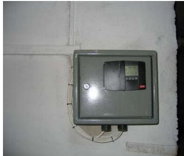
Тепловые пункты после реализации проекта / Контроллеры, установленные для каждого теплопункта
